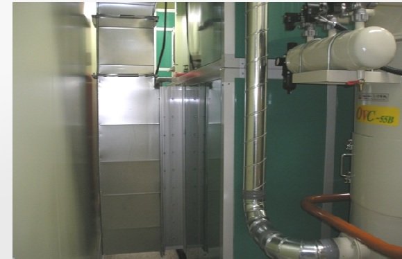
EXHAUST DUCT 설치
