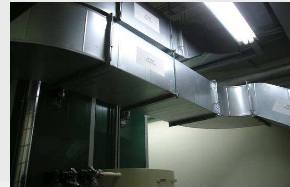
EXHAUST DUCT 설치
