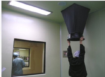
HEPA FILTER 풍속 측정
